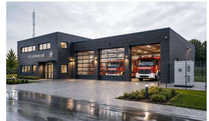
Resiliente KRITIS-Energieversorgung mit BESS
