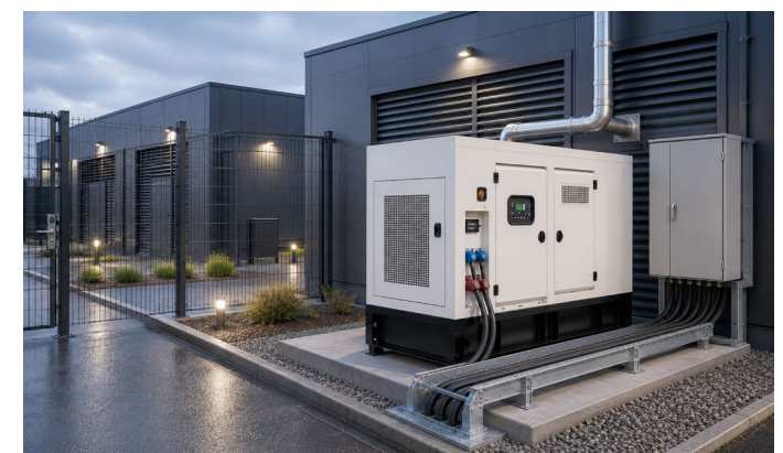
Dieselgestützte Ersatzstromversorgung für Rechenzentren
